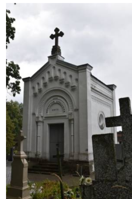
Fot. 4. Pratulín. Kaplica grobowa.
