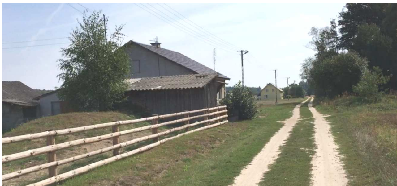
Fot. 4 . Widok na budynek drewniany – obiekt przeznaczony do rozbiórki.
