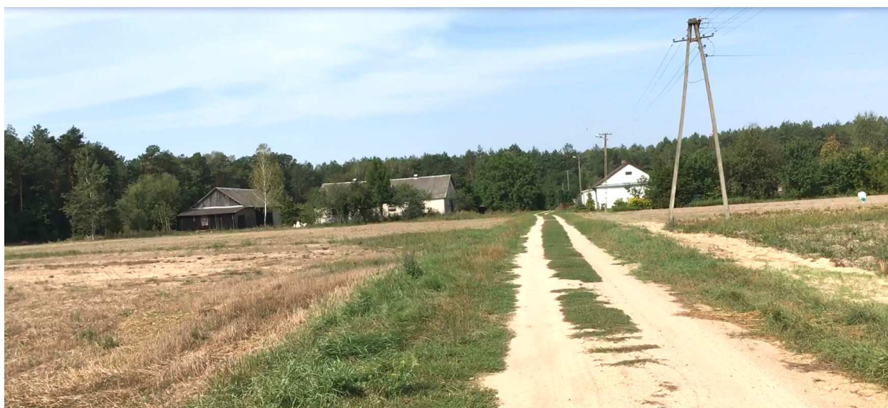
Fot. 4 . Widok drogi gminnej nr 100256L w km 1+300.
