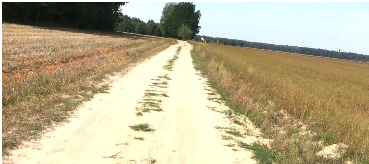
Fot. 1 . Widok od strony drogi powiatowej 1039L
