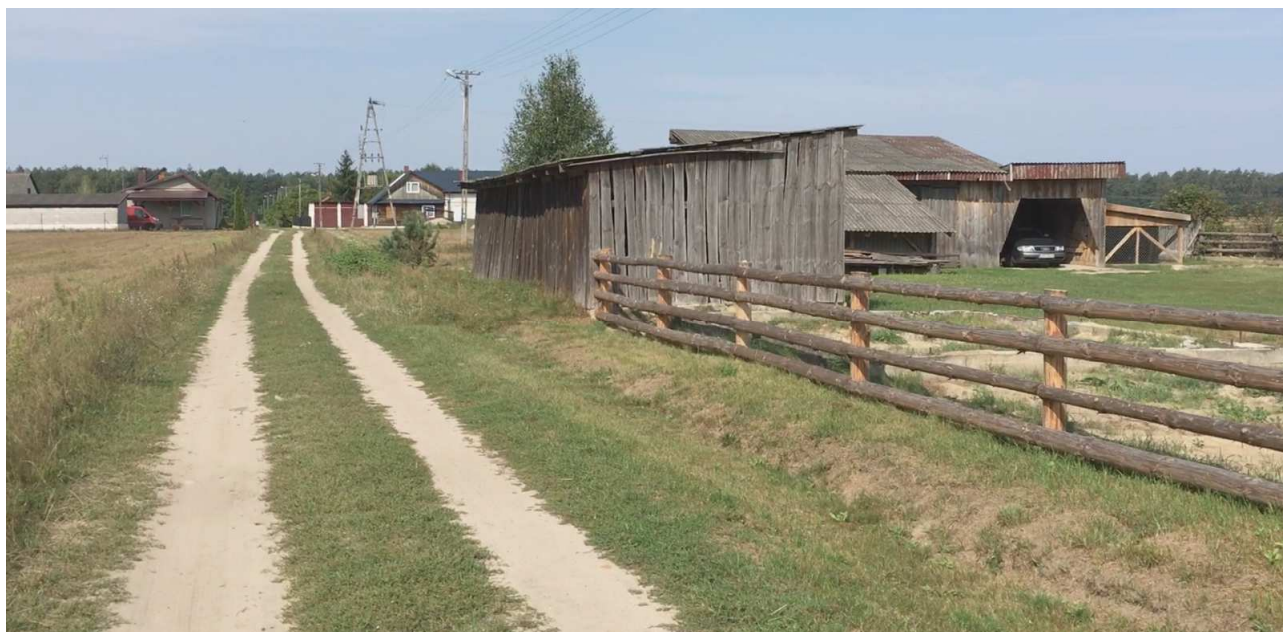
Fot. 3 . Widok na budynek drewniany oraz fundamenty – obiekty przeznaczone do rozbiórki.
