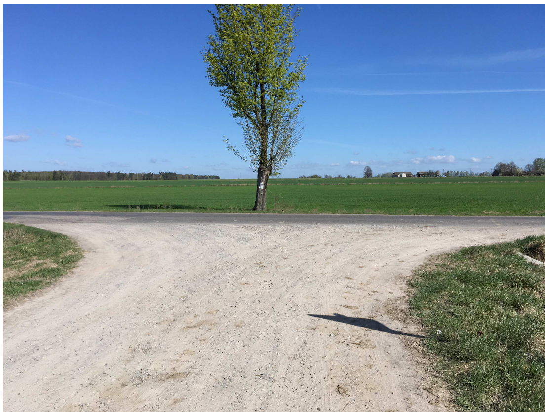
Fot. 1 . Widok na połączenie drogi gminnej nr 100242L z drogą powiatową nr 1035L.
