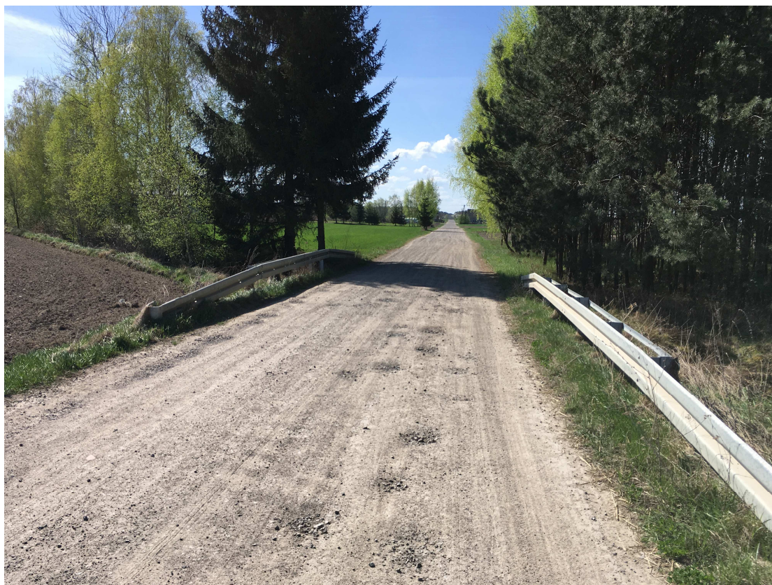
Fot. 2 . Widok barier przeznaczonych do przestawienia.
